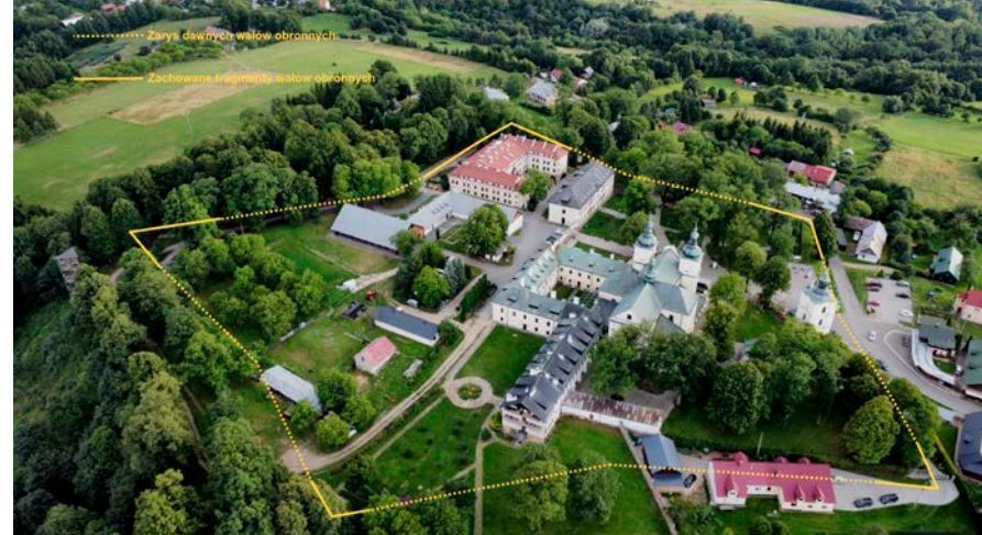
Fot. 30. Widok na Kalwarię z lotu ptaka z zarysem dawnych wałów obronnych (RP)
