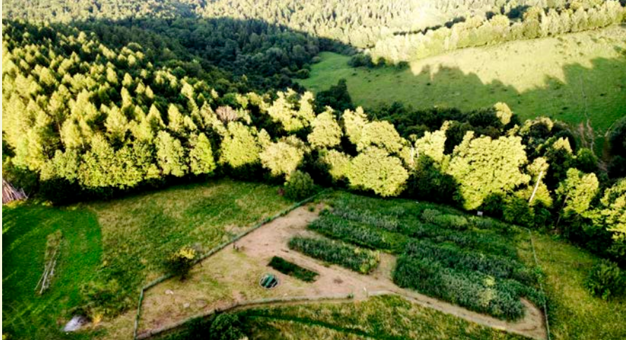
Fot. 25. Oczyszczalnia ścieków z lotu ptaka z dobrze widocznymi poletkami trzcinowymi (RP)
